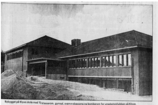
Nybygget på Klyve skole med 10 klasserom, gymnastikkhall, svømmebasseng og bomberom for ungdomsklubben på Klyve.
