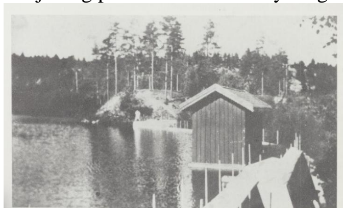
Klyvedammen. Porsgrunn kommune anla et vannverk her i 1868. Det leverte vann til Vestsidens befolkning. I damveggen var det ei luke. Vannet rant gjennom luka til «Mølleren», en liten dam nedenfor, og videre til Mølla.
